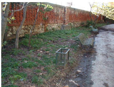
il confine con il muro esistente
